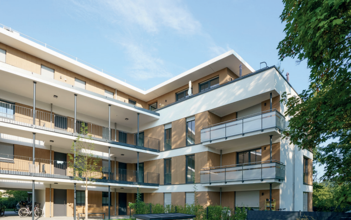
Großreuther Straße Nürnberg: Wohnanlage mit 42 modernen Eigentumswohnungen, Fertigstellung 2024
